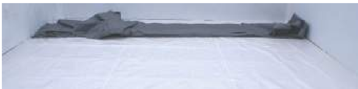
Figure 32 – Разворачивание лайнера
