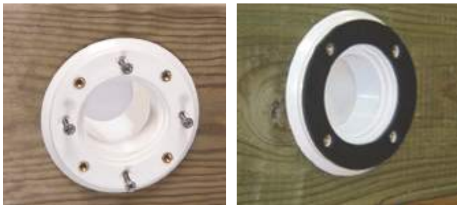
Figure 23 – Монтаж корпуса возвратной форсунки и уплотнения
